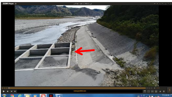
圖三：卑南溪下游格框丁壩和護腳工 （107 年空拍圖，第八河川局提供）
