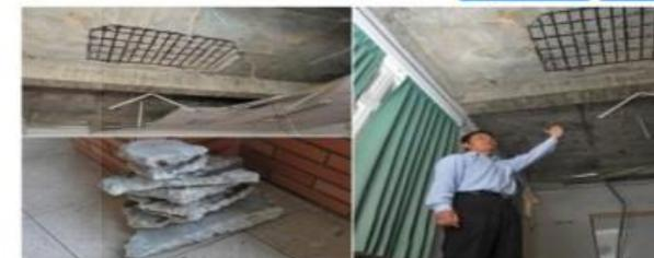
崩落的天花板可以看到鋼筋外露，在確保絕對安全以前，這幢大樓將停止使用。(中時電子報圖)
