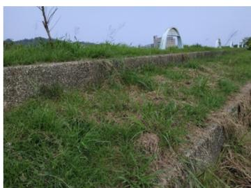
圖 41 有水洗石子分隔的鋪面
