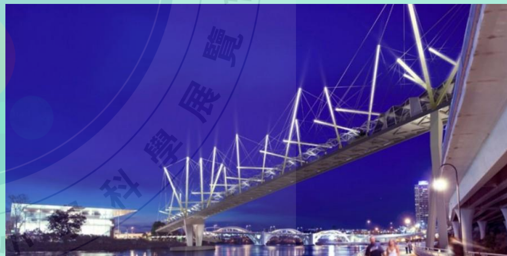
張拉整體(Tensegrity)運用在橋梁建構(圖三)
