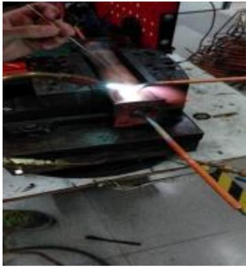
圖 46 焊接殼管式熱交換器
