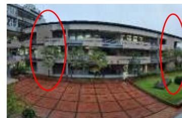
圖 1-3：學校建物補強之剪力牆結構
