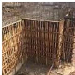
圖 1-2：剪力牆的施工過程 [參考資料二]
