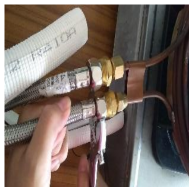
圖 73連接水循環金屬管線
