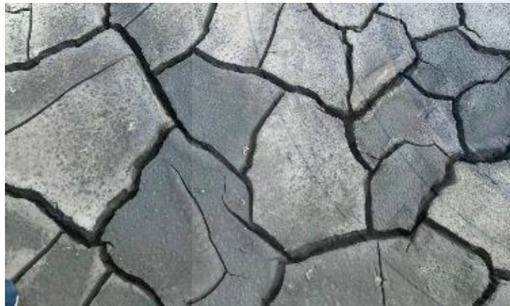
滾水坪泥裂圖
