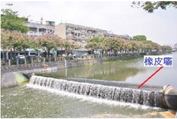
圖 15.萬年溪改造工程～橡皮壩工程引溪水至復興公園型水域
