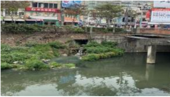
圖 13.從長春橋到玉皇宮前的水利工程→箱涵
