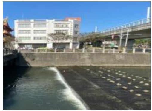
圖 12.從長春橋到玉皇宮前的水利工程→固床工
