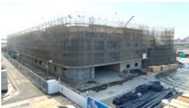
圖 11. 長春橋平日車水馬龍的街景、附近興建大型停車場(共三處分別為夜市、公園、勝利路上)
