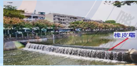
圖15.萬年溪改造工程～橡皮壩工程引溪水至復興公園型水域
