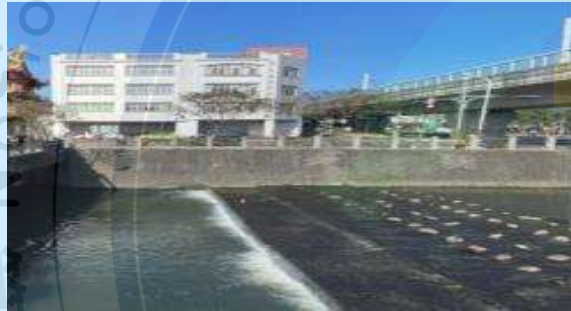
圖12.從長春橋到玉皇宮前的水利工程→固床工
