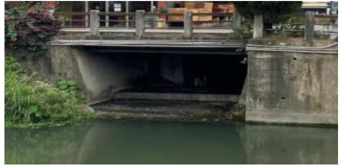
圖 13.從長春橋到玉皇宮前的水利工程→箱涵
