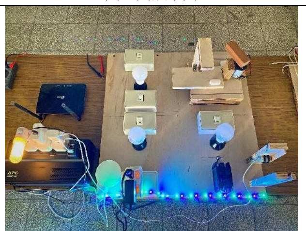
圖 45、家用電斷電時，小夜燈、LED 燈條和大門門鎖依然正常運作
