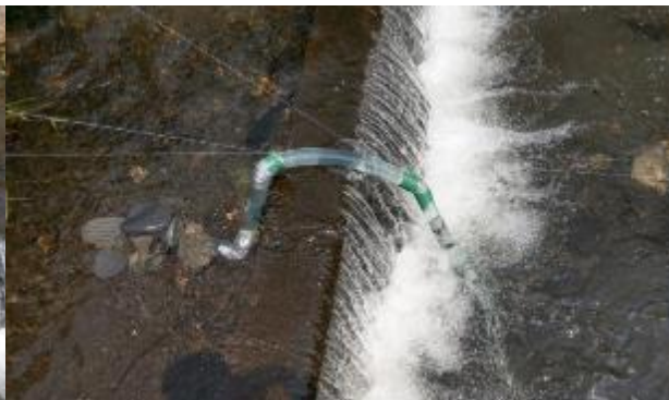
左圖：填充魚道， 右圖：用水線和石頭固定魚道
