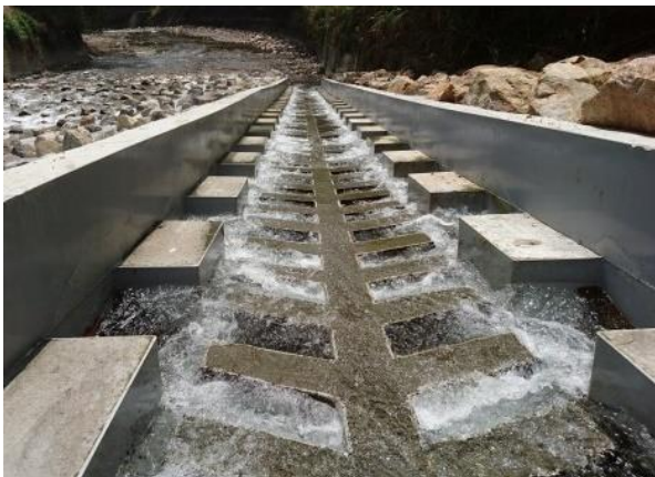
水路式魚道(魚骨形魚道)
