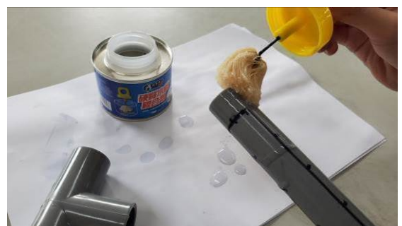
圖 4-1-7 利用硬質水管膠合劑連接水管
