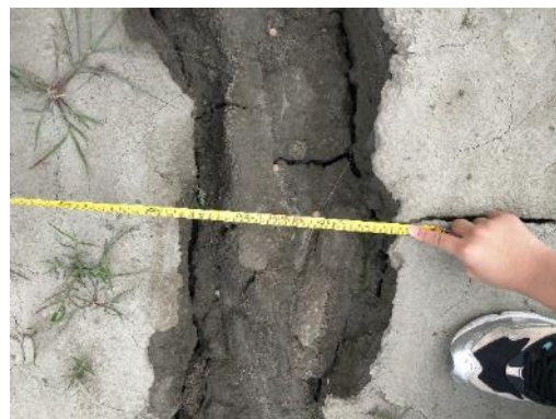
照片 43 下游埤底溝的泥裂寬度最大可達 30 公分。
