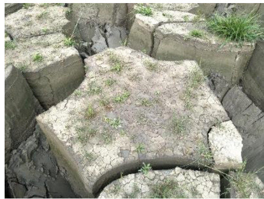
照片 62 崩塌的泥裂加大了泥裂的縫隙，上層的泥裂看起來比較有層次。
