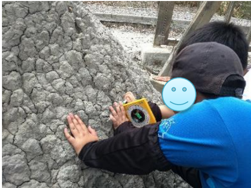
照片 18 東北邊坡脊部測得傾斜角為 53 度。
