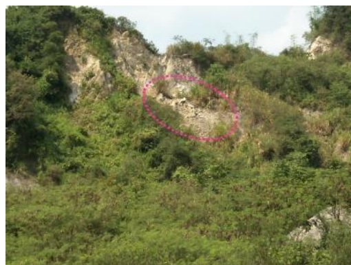
照片 27 遠處的厚層砂岩下有明顯的岩塊崩落。
