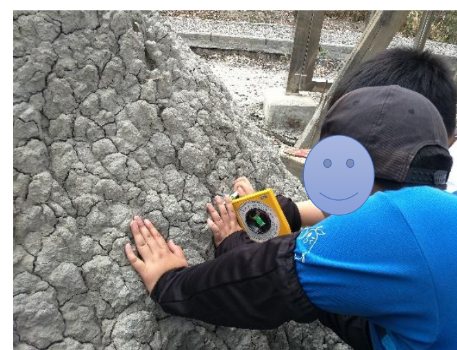
照片18 東北邊坡脊部測得傾斜角為53度。
