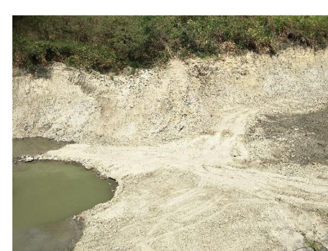
照片12 泥岩挖完露出古亭坑泥岩層，這是湖泊的底部。可以看到降雨造成泥岩的大量淤積。
