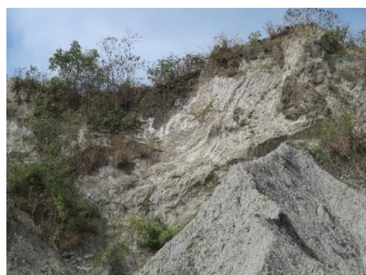
照片 30 泥岩上的厚層砂岩可以看到明顯的網狀裂痕。
