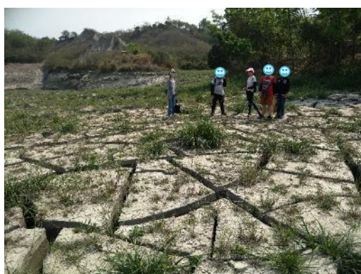
照片 57 牛埔農塘東邊的個別泥裂面積較小，屬較泥質的泥岩。
