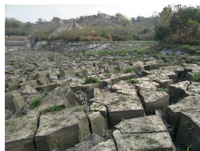
照片59 牛埔農塘北邊的開挖造成南邊、東邊和西邊的泥裂失去重心而往北邊傾斜。
