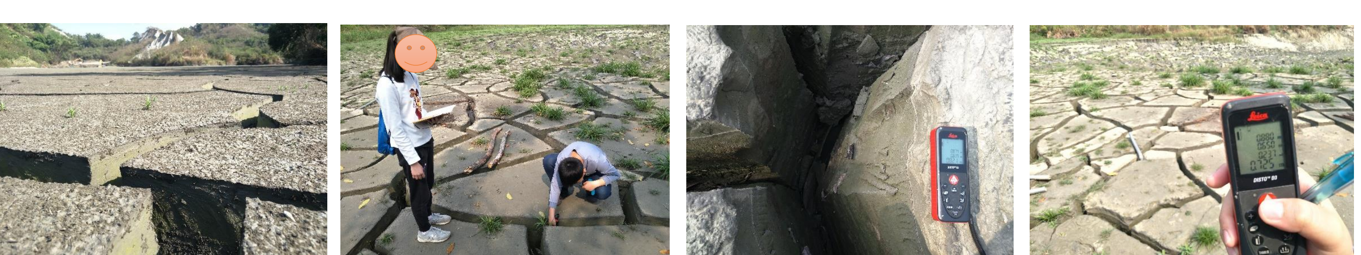
照片38 泥裂的裂開的角度幾乎接近九十度。 照片39 實際量測泥裂的寬度和深度。 照片40 泥裂的深度使用測距儀可以非常準確測量。 照片41 牛埔農塘的泥裂深度都沒有超過一公尺。
