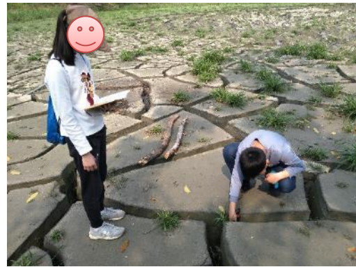
照片 39 實際量測泥裂的寬度和深度。
