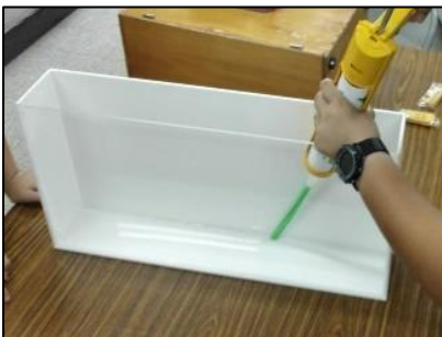
圖 6-3 使用矽利康來塗抹水箱接縫
