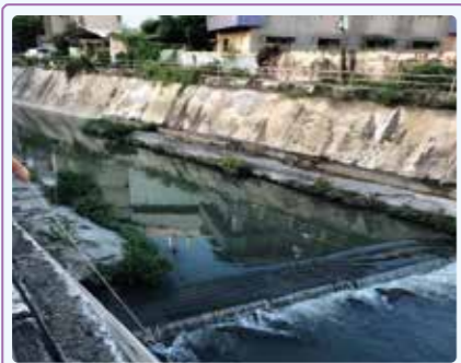
殺蛇溪水泥護岸 (東匯橋)
